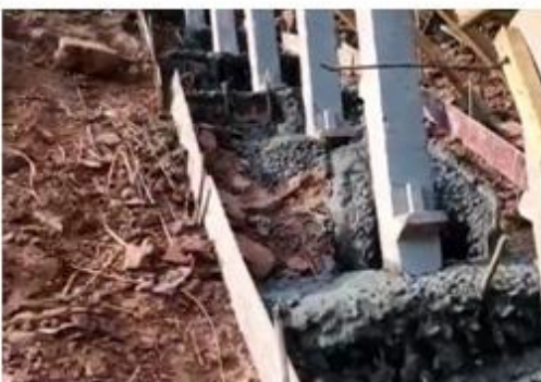
Заливка бетона в горах
